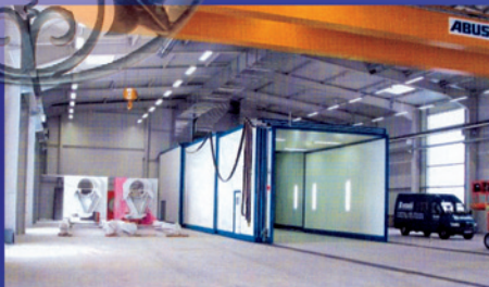
Teleskoptunnel, seit 2005 in Magdeburg in Betrieb
