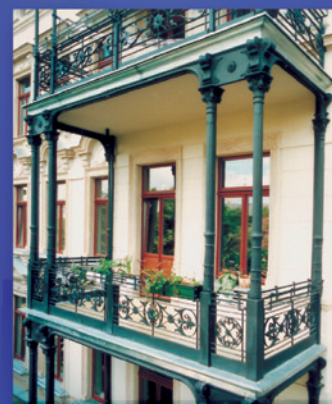
August-Bebel-Straße, Leipzig, gusseiserne Säulen und schmiedeeiserne Geländer
