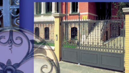
Tor und Zaunanlage, Erich-Zeigner-Allee
